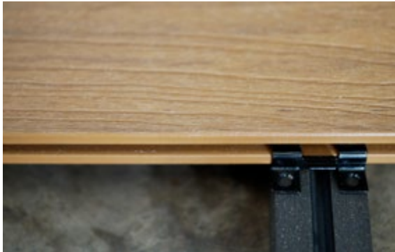
Detalle sujeción de lama con clip
