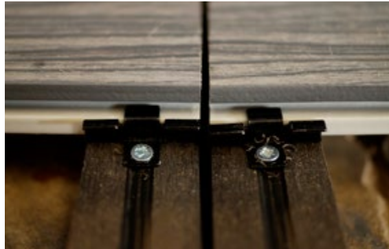
Doble rastrelado entre testas con clip para cada lama
